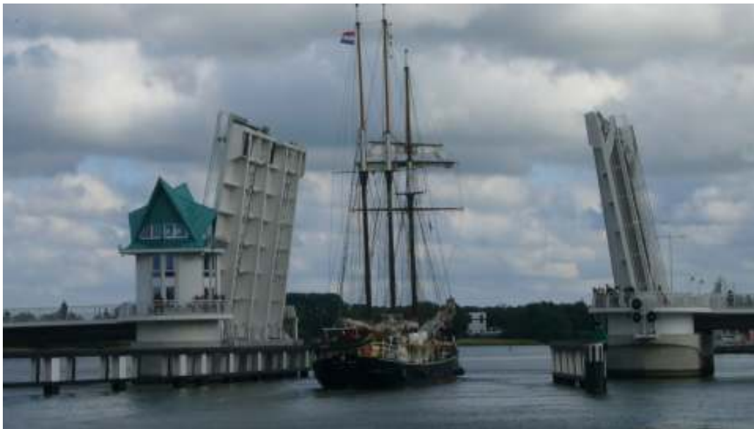
Die neue Klappbrücke in Kappeln
